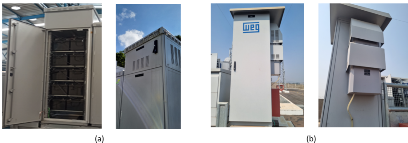
Figura 3 – Painéis instalados na SECI Primeira Geração: (a) Refrigeração no teto; (b) Refrigeração na lateral.
