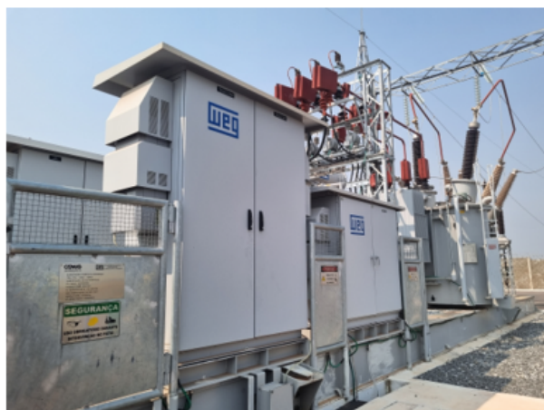
Figura 2 - SECI Primeira Geração: painéis de proteção e controle instalados ao tempo, sobre o chassi.
