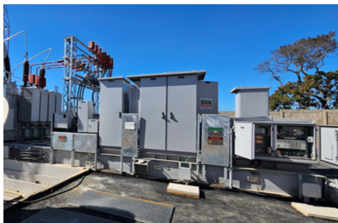
Figura 2 - SECI Primeira Geração: painéis de proteção e controle instalados ao tempo, sobre o chassi.
